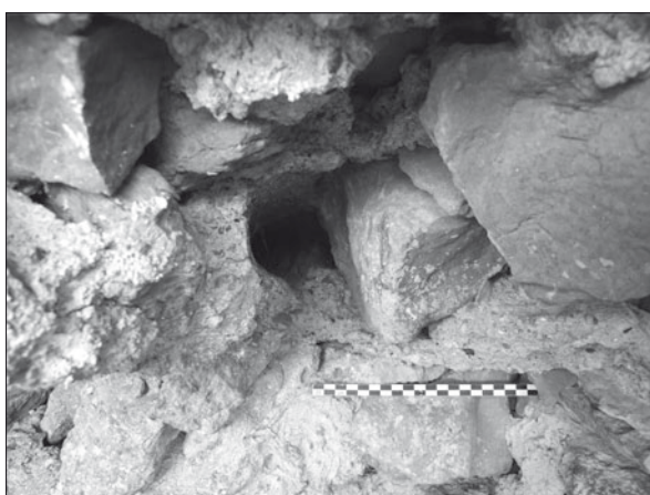
Fig. 12 : Vaudémont, trou de boulin de section circulaire.
