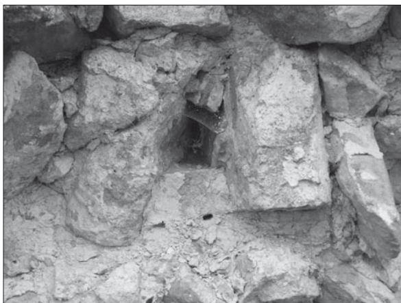
Fig. 8 : Fontenoy-le-Château, mortier très liquide formant une surface plane.
