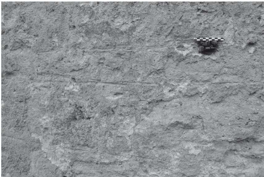
Fig. 15 : Blâmont, traces de joints tires au fer.
