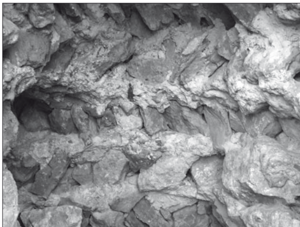
Fig. 6 : Vaudémont, blocage en épi et couche de mortier épaisse.
