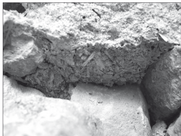
Fig. 23 : Vaudémont, deux lits de mortiers séparés par une fine couche de terre et végétaux ; mise en évidence des végétaux pris dans le mortier supérieur.
