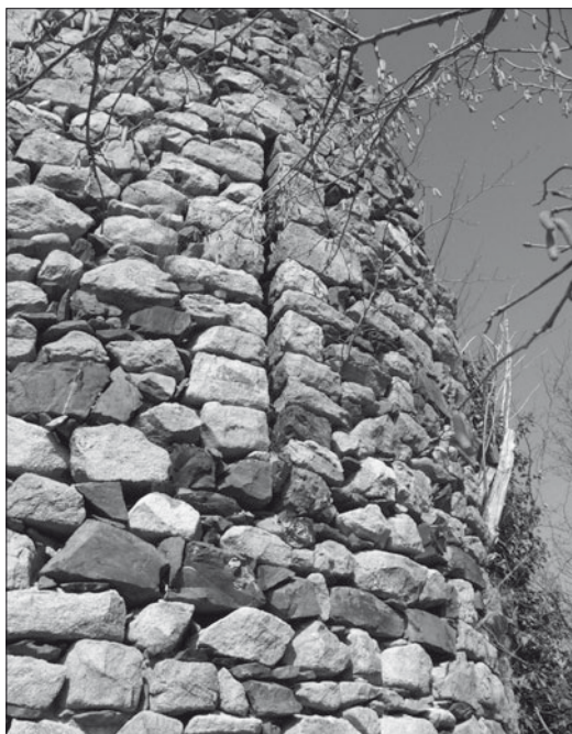
Fig. 10 : Schrankenfels, parement irrégulier.
