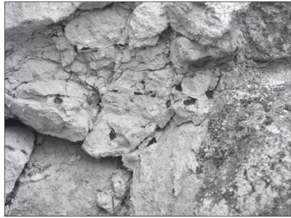
Fig. 21 : Fontenoy-le-Château, mortier avec inclusions de charbon de bois.
