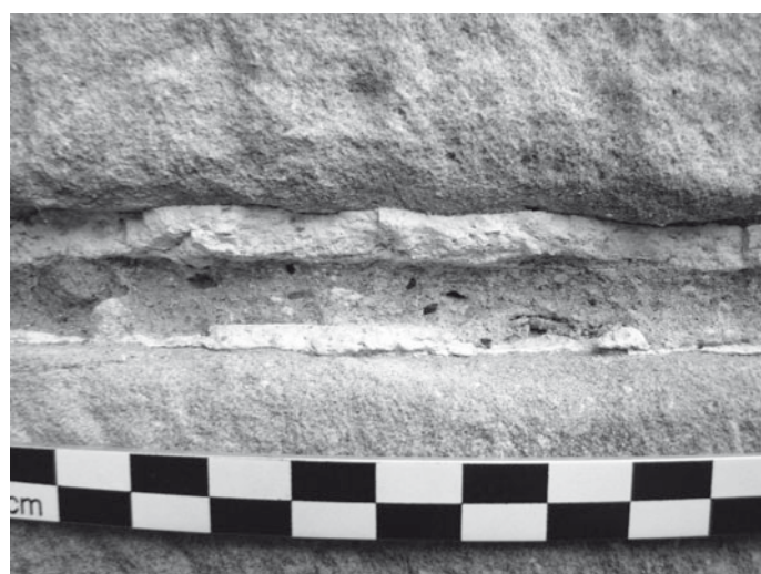
Fig. 13 : Xugney, mortier de pose entre deux restes d'un pré-enduit couvrant.
