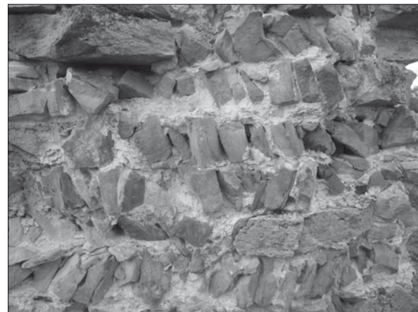
Fig. 7 : Fontenoy-le-Château, blocage en épi et couche de mortier fluide.
