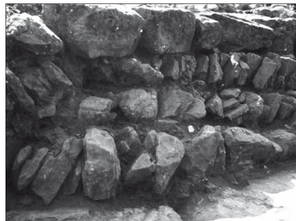
Fig. 9 : Warthenberg, blocage lié à la terre et au sable.
