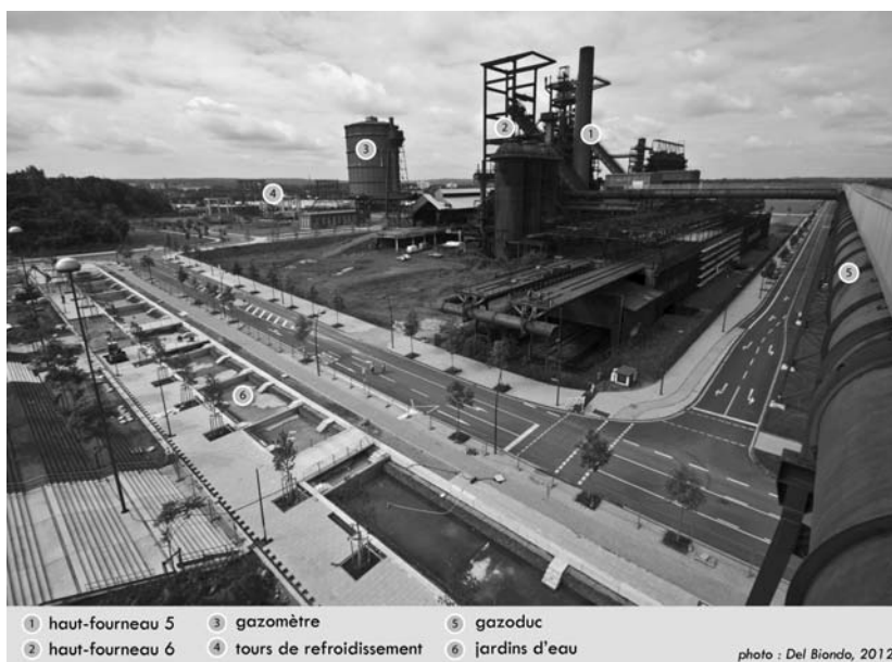
Fig. 6 Les hauts-fourneaux 5 et 6 du site de Phoenix à Dortmund (Allemagne) : une mise en patrimoine inachevée, dans l'attente d'un repreneur privé
