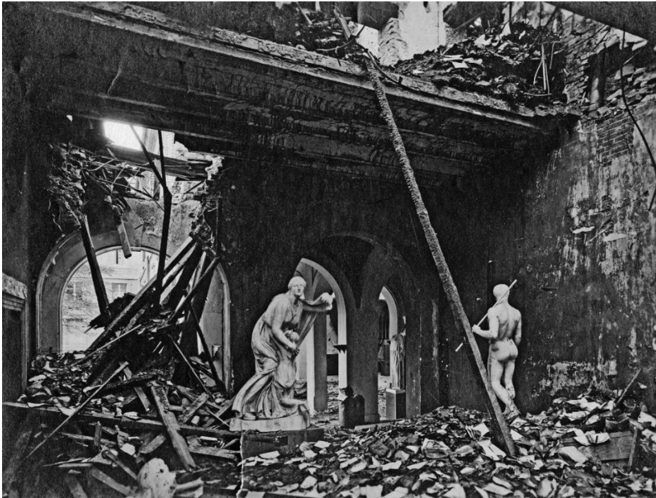
Ancien musée archéologique et premier étage de la bibliothèque après l'incendie
