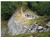
- The « Pont des Fées » An enigmatic structure
