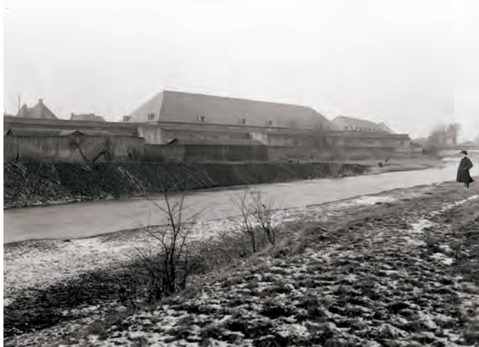
Remblaiement du mur en Chadeleirue, près du pont Sainte-Barbe en 1911 (Musée de La Cour d'Or-Metz Métropole)
