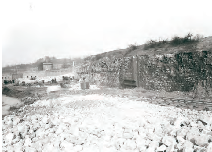
Remblaiement de la Seille en 1911 au sud du pont des Grilles de la Basse-Seille (Musée de La Cour d'Or-Metz Métropole)
