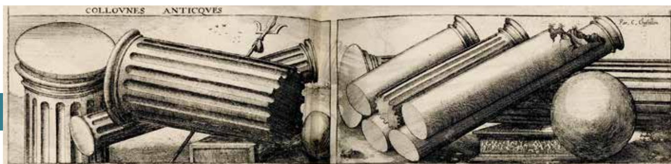
Fig. 3 : Des fûts de colonnes antique sont encore visibles à Metz au début du XVII e siècle, notamment près de la cathédrale et de la porte du Pont-des-Morts [C. Chastillon, Topographie française ou représentation de villes, bourgs, châteaux, maisons de plaisance, ruines et vestiges d'antiquités du royaume de France , Paris, Boisseau, 1655, p. 106] [Bibliothèque de l'Institut National d'Histoire de l'Art, collections Jacques Doucet].
