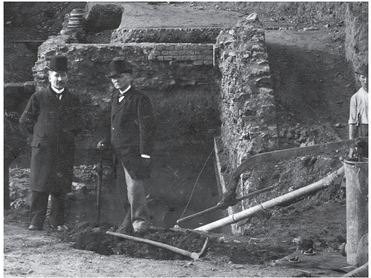
Fig. 7. Système de pompage (à droite) photographié lors d'une visite de la Gesellschaft en mai 1903 (© Musée de La Cour d'Or – Metz Métropole).
