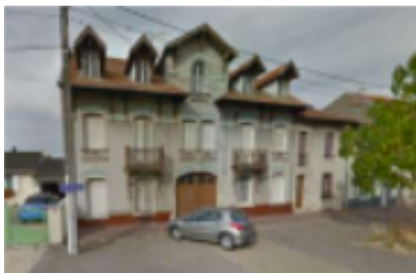
Figure 29 : logement bourgeois datant de l'Entre Deux Guerres à Moncel-sur-Seille (Source : PLUi du Grand Couronné)
