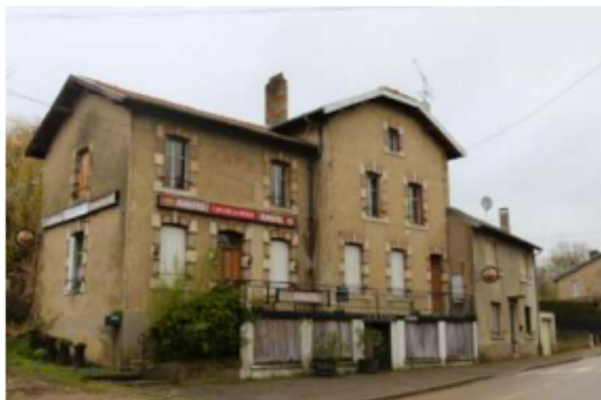
Figure 33 : immeuble datant de la période d'Entre Deux Guerres à Nomeny
