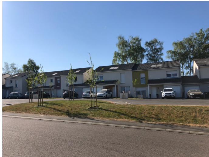
Figure 7 : lotissement périurbain à Marly (21 mai 2020)
