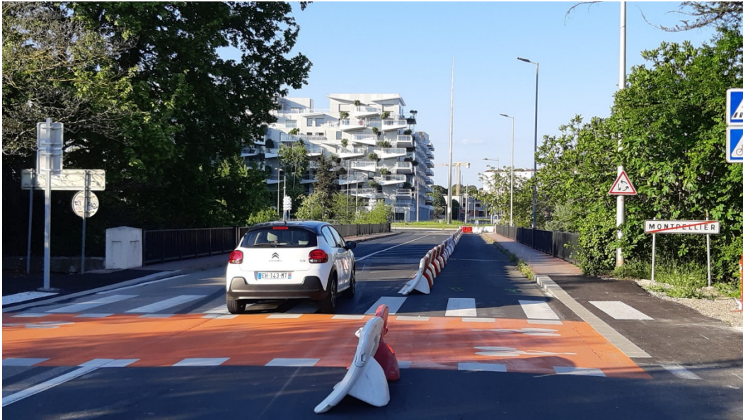
Figure 9 : piste cyclable temporaire réalisée le long d'une route, à Montpellier
