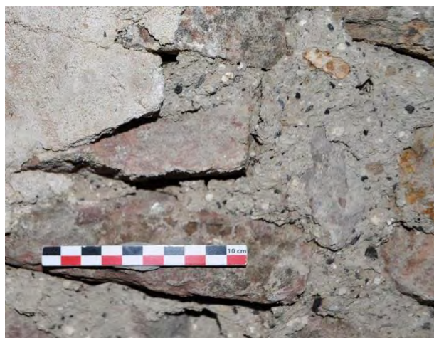
Fig. 61 – Mortier de charbon et de cendre, m2 (cliché © C. Moulis).
