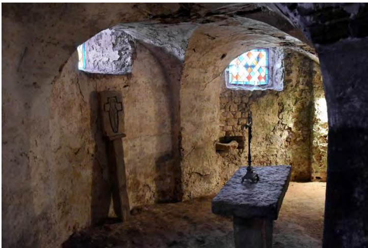
Fig.46 – Fenêtres de la crypte, dépassant des voûtes (cliché © C. Moulis).
