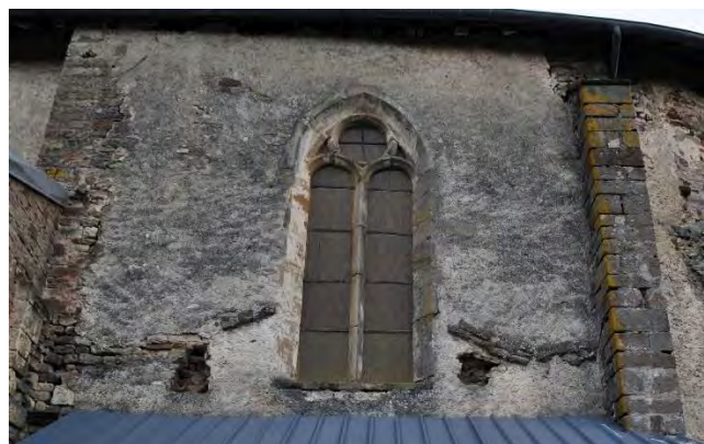
Fig.36 – Solin coupé par une baie gothique (cliché © C. Moulis).
