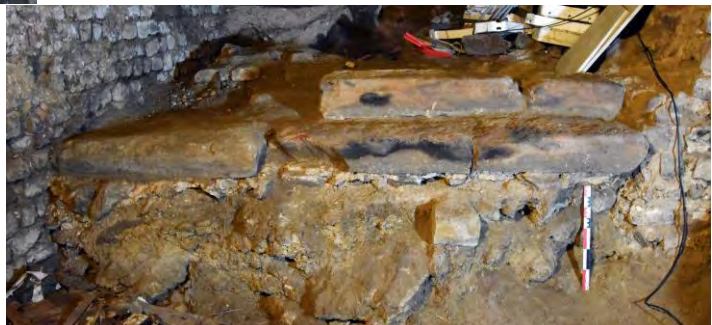
Fig.68 – Marches observées sous le bas-côté sud (cliché © C. Moulis).
