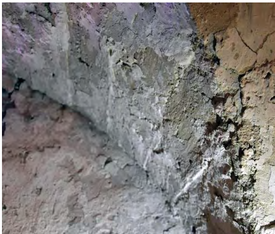
Fig. 60 – Négatifs de couchis dans la voûte de la crypte (cliché © C. Moulis).
