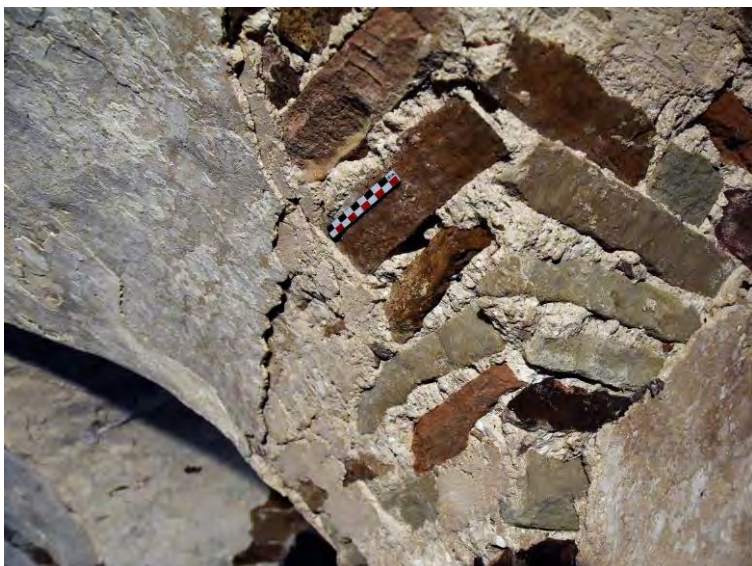
Fig.63 – Mortier primitif des voûtes avec enduit au contact du coffrage (au centre, m1), recouvert ensuite par un enduit taloché (à gauche, m3) (cliché © C. Moulis).
