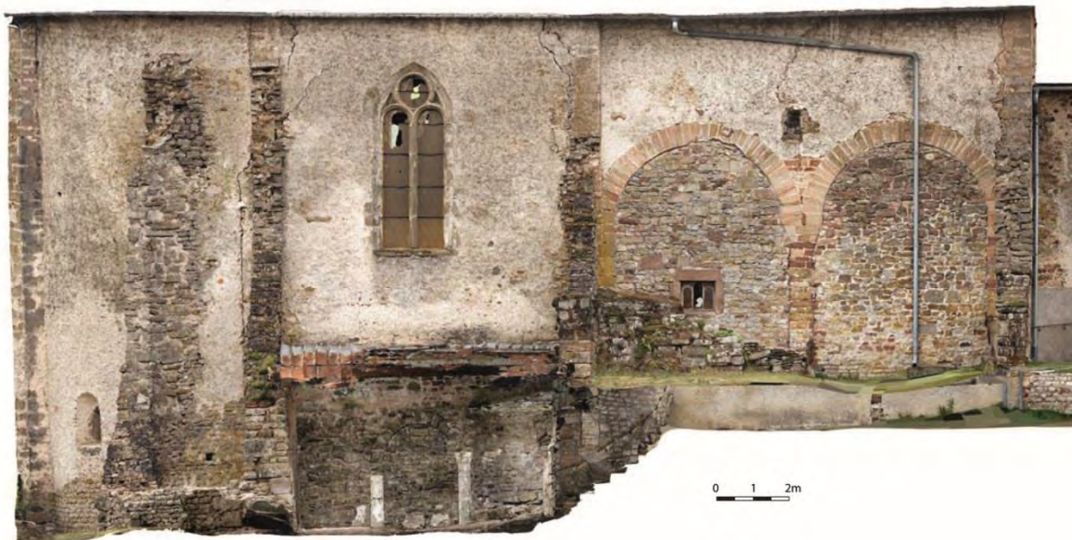
Fig.37 – Photogrammétrie des élévations nord : chevet - transept - nef (acquisition © R. Janvier).
