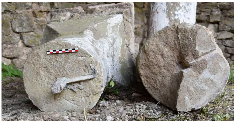
Fig.56 – Goujon scellé au plomb de la colonnette n°7 (cliché © C. Moulis).
