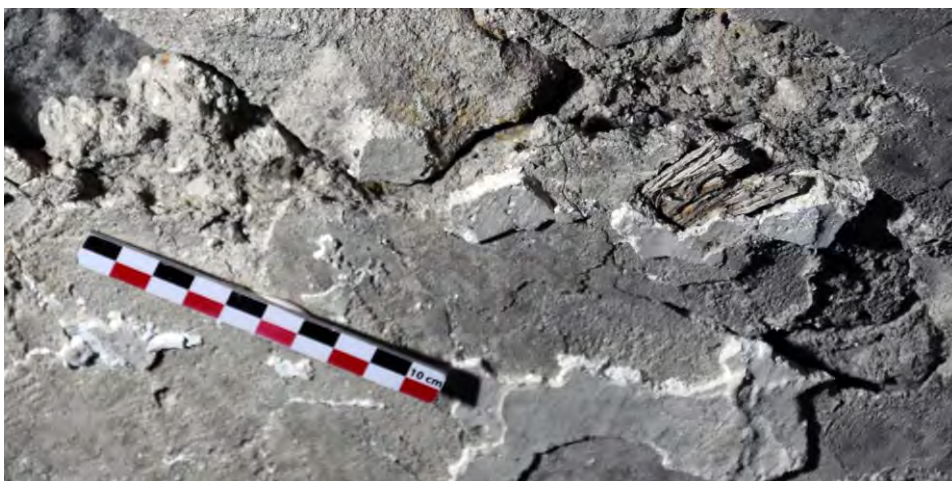
Fig. 62 – Fragment de couchis piégé dans le mortier m1, recouvert ensuite par m3, m4 et m5 (cliché © C. Moulis).
