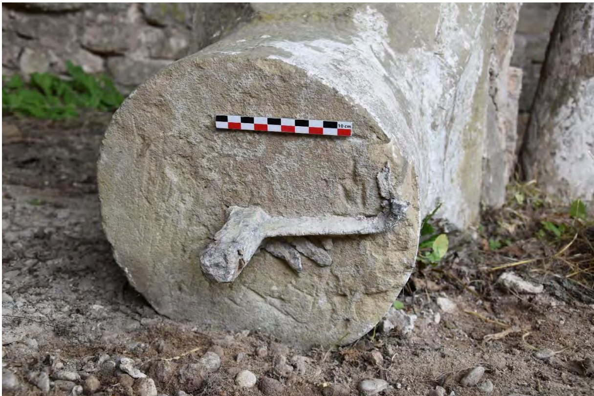
Fig. 1 : Cliché d'un goujon engagé dans le lit de pose d'une colonne
