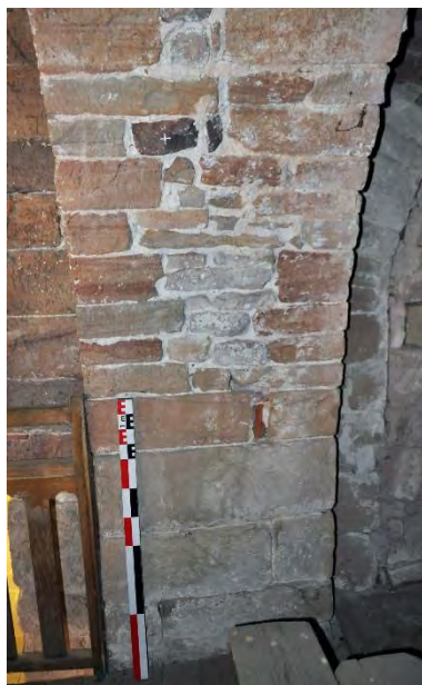
Fig.22 – Largeur des arcades, côté sud de la travée 1 (cliché © A. Lugand).
