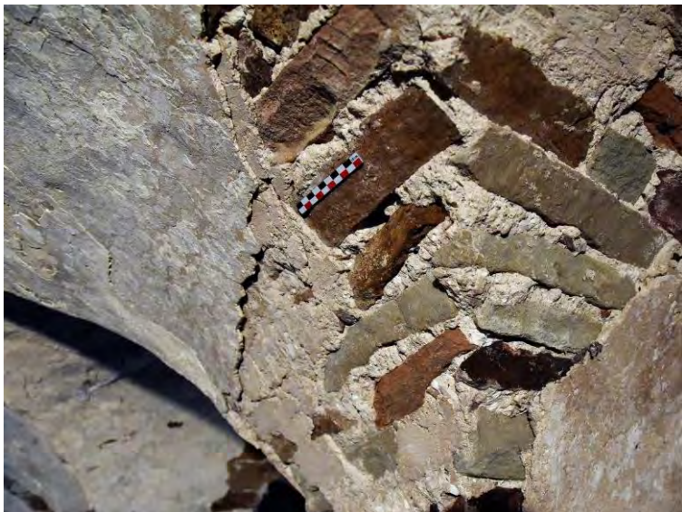
Fig.63 – Mortier primitif des voûtes avec enduit au contact du coffrage (au centre, m1), recouvert ensuite par un enduit taloché (à gauche, m3) (cliché © C. Moulis).
