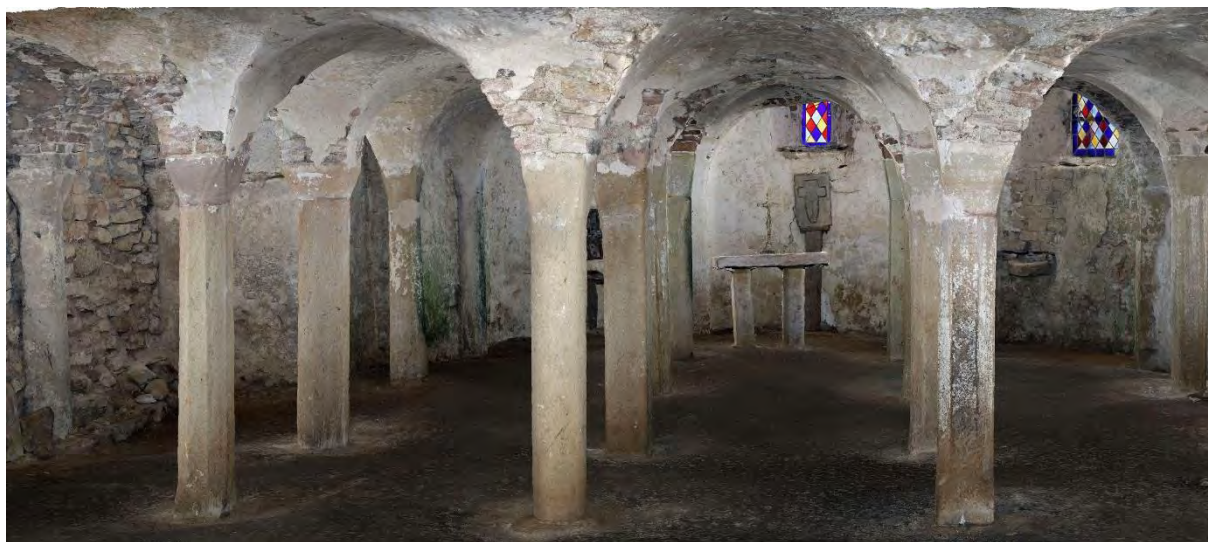
Fig.45 – Partie centrale de la crypte (acquisition © R. Janvier).
