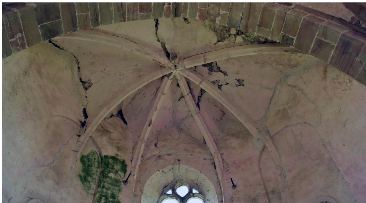
Fig.38 – Nervures de la voûte du chœur (cliché © C. Moulis).
