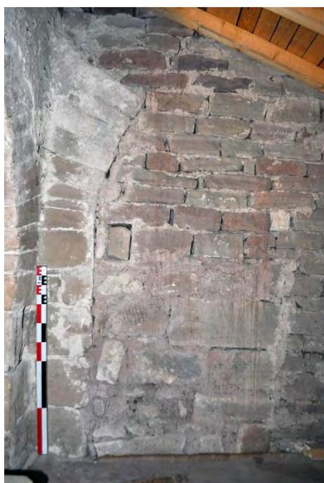
*Fig.27 – Départ d'arc doubleau dans le bas-côté sud
