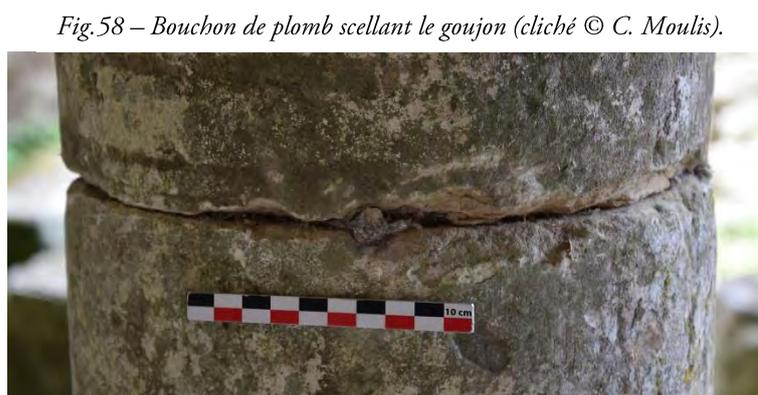
Fig.58 – Bouchon de plomb scellant le goujon (cliché © C. Moulis).
