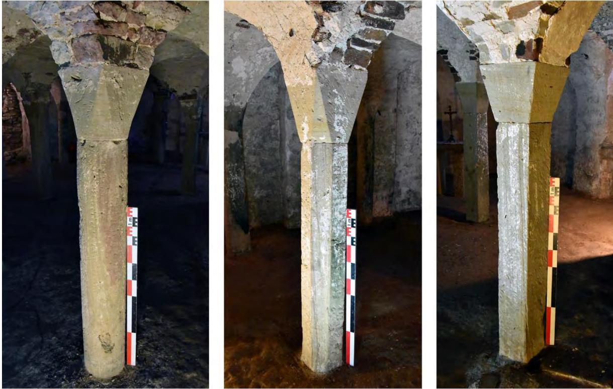
Fig.53 – Colonnettes de la crypte de type 1 (circulaire, n°31), type 2 (octogonale, n°23), de type 3 (carrée, n°33)
