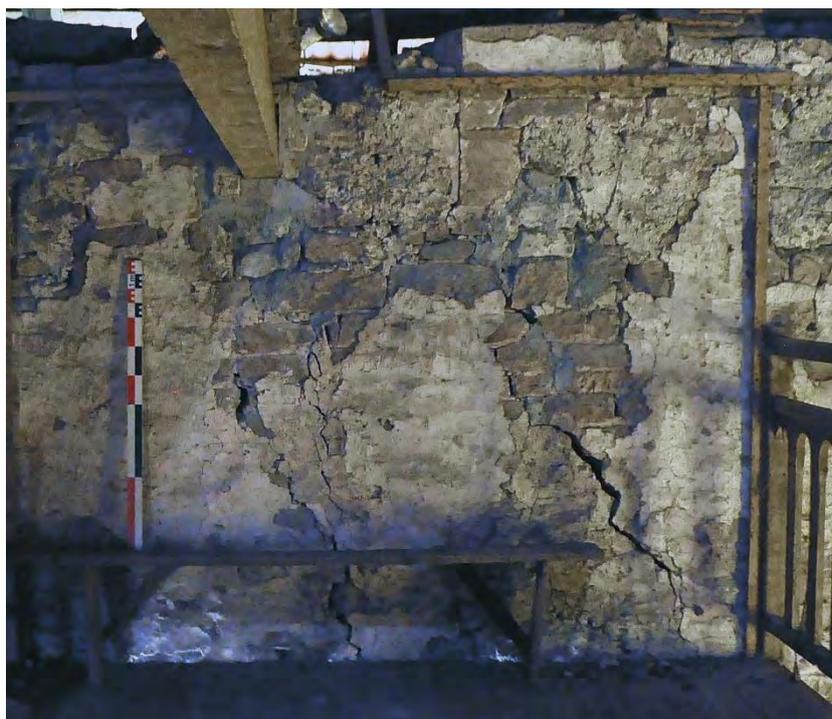
*Fig.26 – Indice de fenêtre haute dans le mur gouttereau nord (cliché © C. Moulis).*
