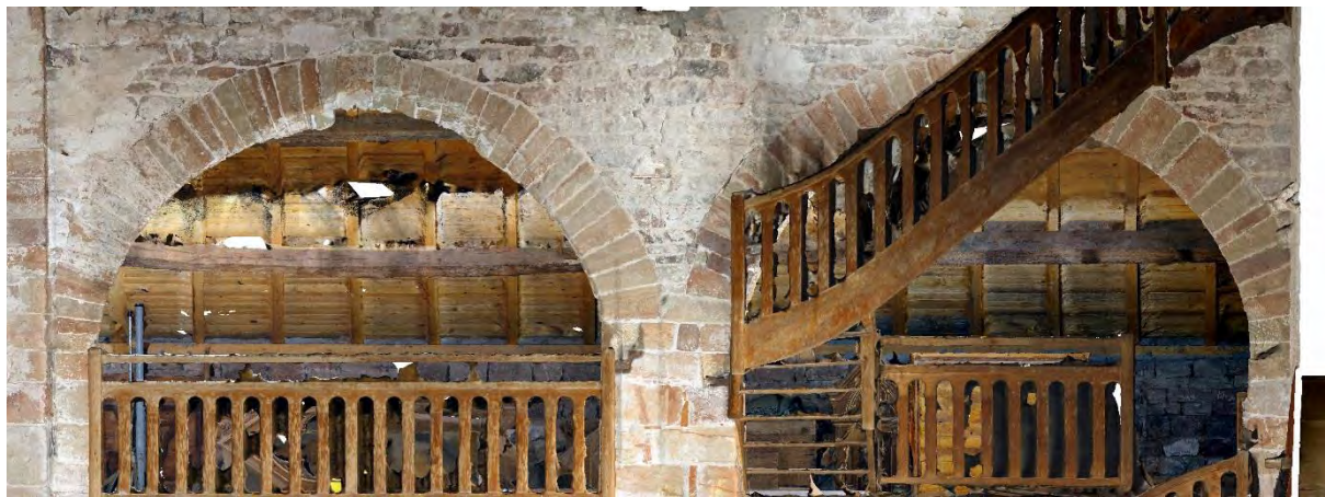
Fig.21 – Arcades nord et sud de la nef (acquisition © R. Janvier).
