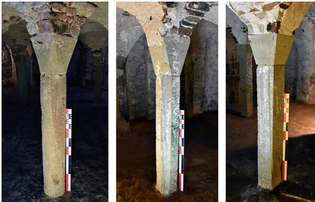
Fig.53 – Colonnettes de la crypte de type 1 (circulaire, n°31), type 2 (octogonale, n°23), de type 3 (carrée, n°33) (clichés © Y. Benaïssa, A. Lazaro).
