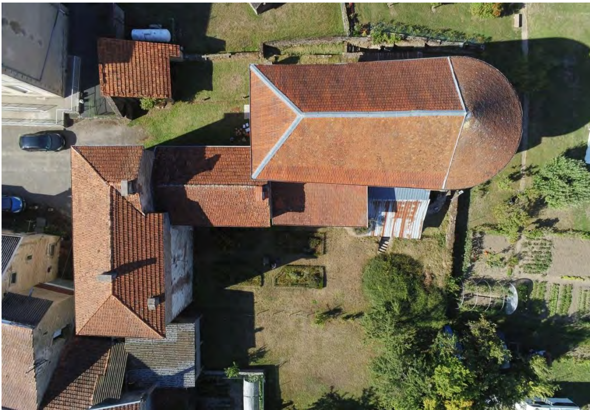
Fig.13 – Vue zénithale du site par drone (cliché © J. Féru).
