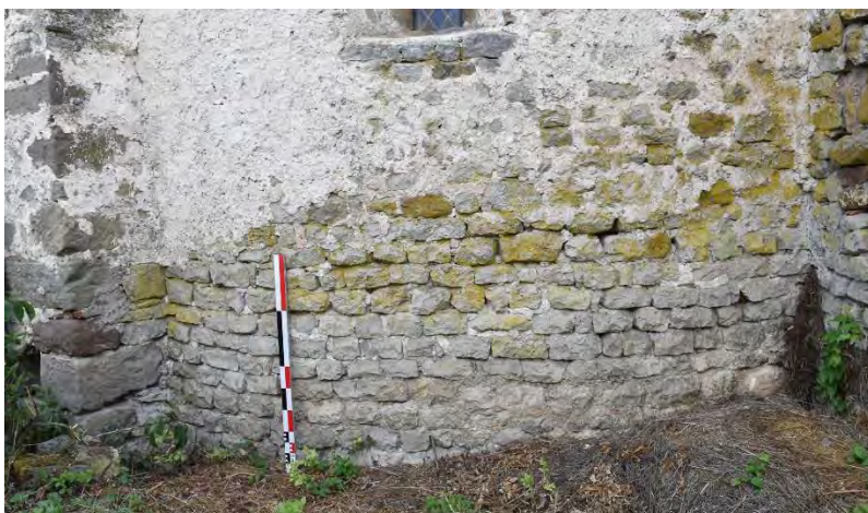
Fig.42 – Parement extérieur à la base du chevet, au nord (cliché © C. Moulis).
