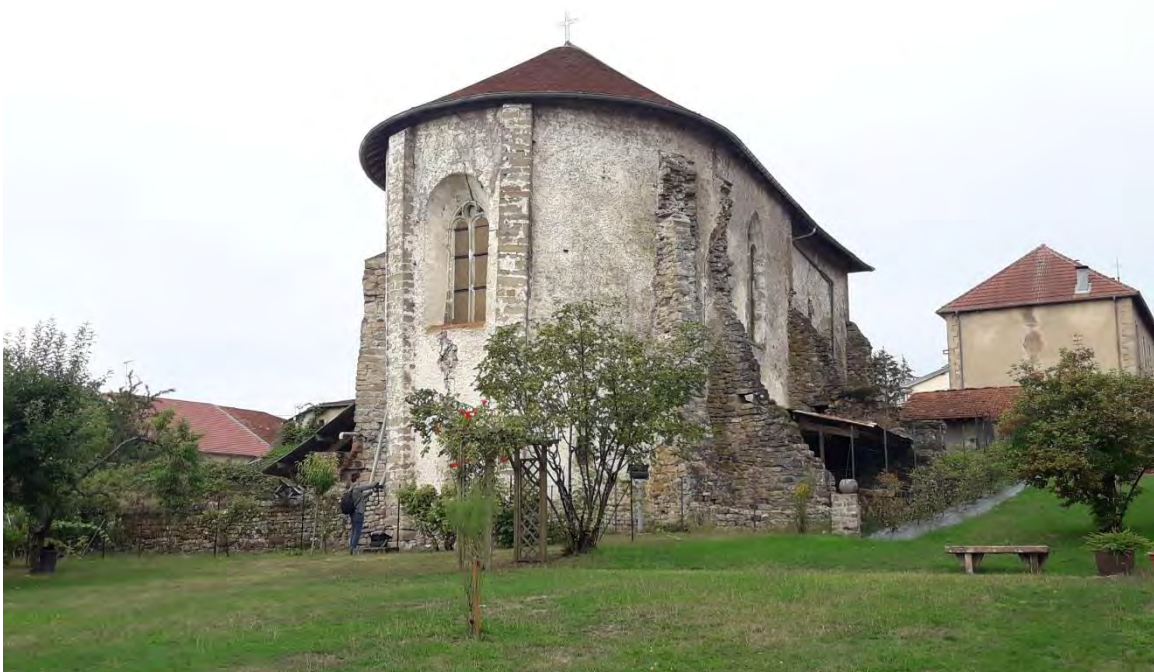
Fig.12 – Vue générale de l'abbatiale depuis le nord-est (cliché © C. Moulis).
