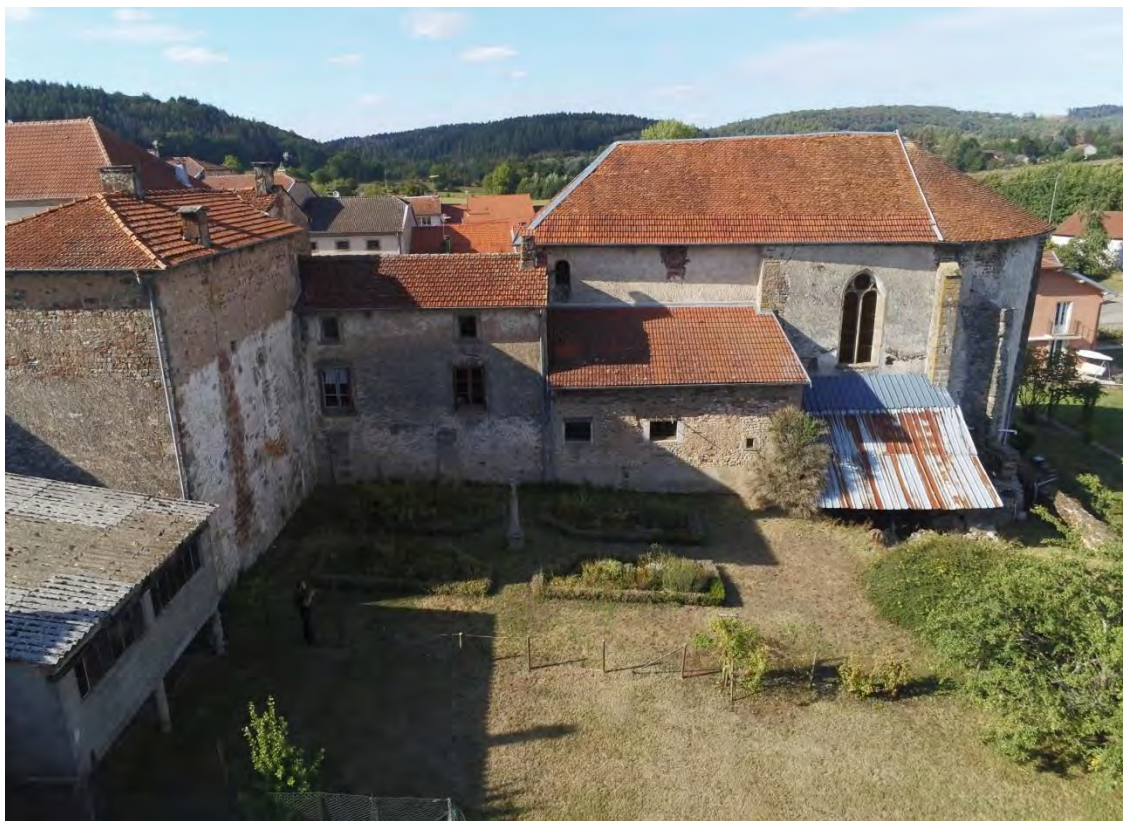
Fig.15 – Vue du sud de l'abbatiale, terrain des anciens bâtiments claustraux (cliché © J. Féru).
