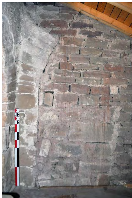
Fig.27 – Départ d'arc doubleau dans le bas-côté sud (cliché © C. Moulis).
