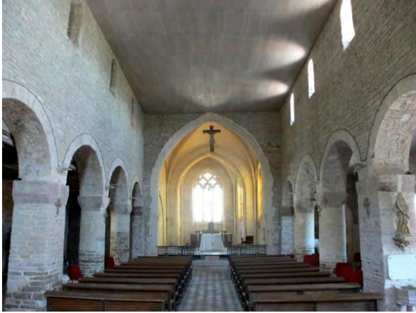
Fig.29 – Nef de Froville (cliché © C. Moulis).
