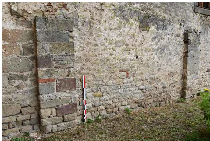
Fig.28 – Les deux contreforts côté cloître au sud (cliché © C. Moulis).
