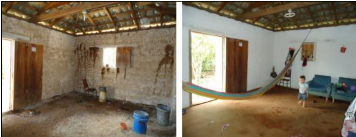
Figure 3-2 Rénovation d'une maison au Salvador initialement touchée par des triatomes (CRDI, consulté le 15/01/2018)
