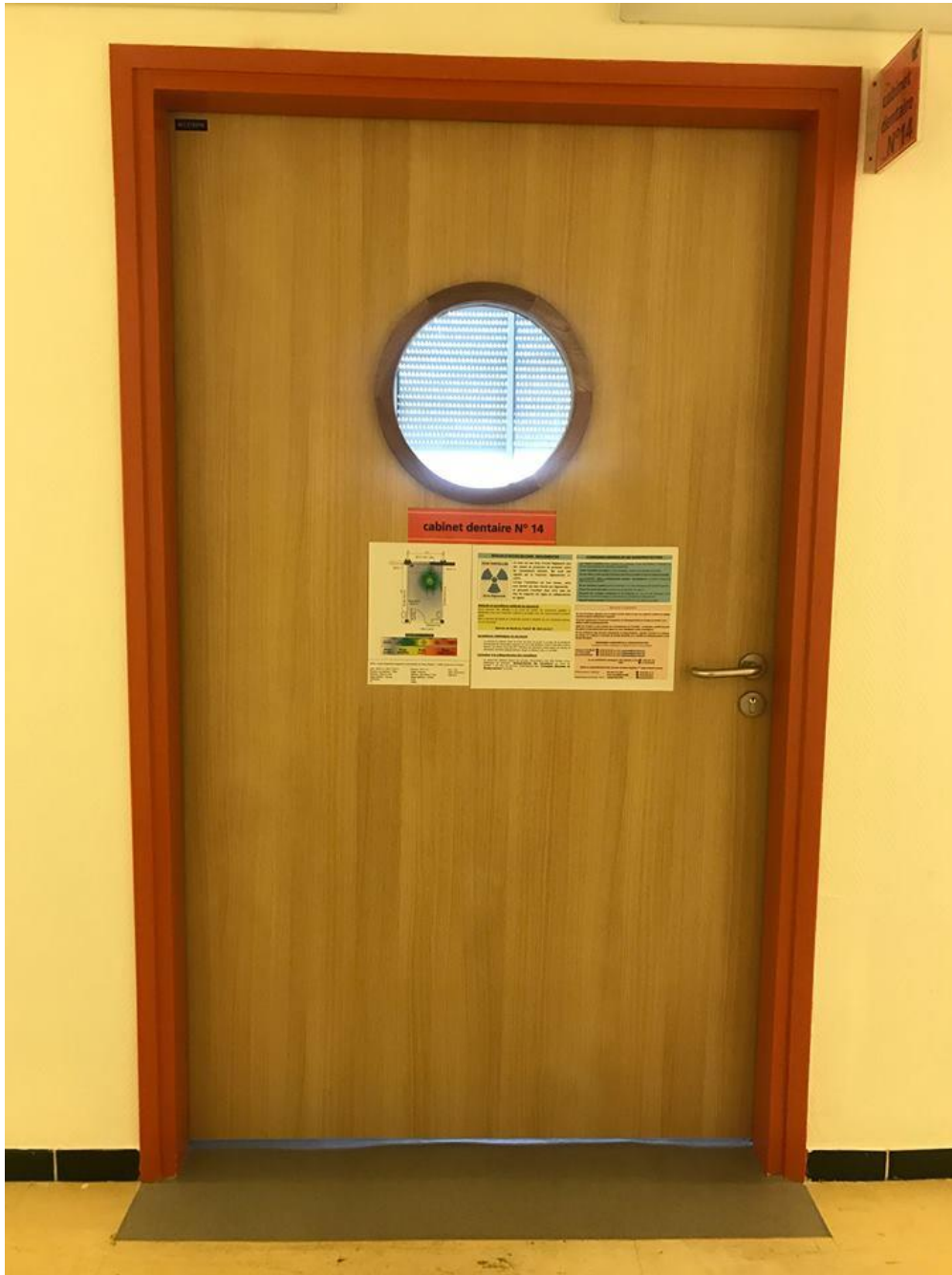
Figure 7 : Département d'odontologie pédiatrique sur site Brabois Adultes : exemple de hublot sur la porte d'accès à la salle de soin (source : document personnel)
