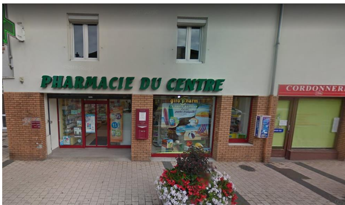
Figure 6 Pharmacie du Centre avant travaux
