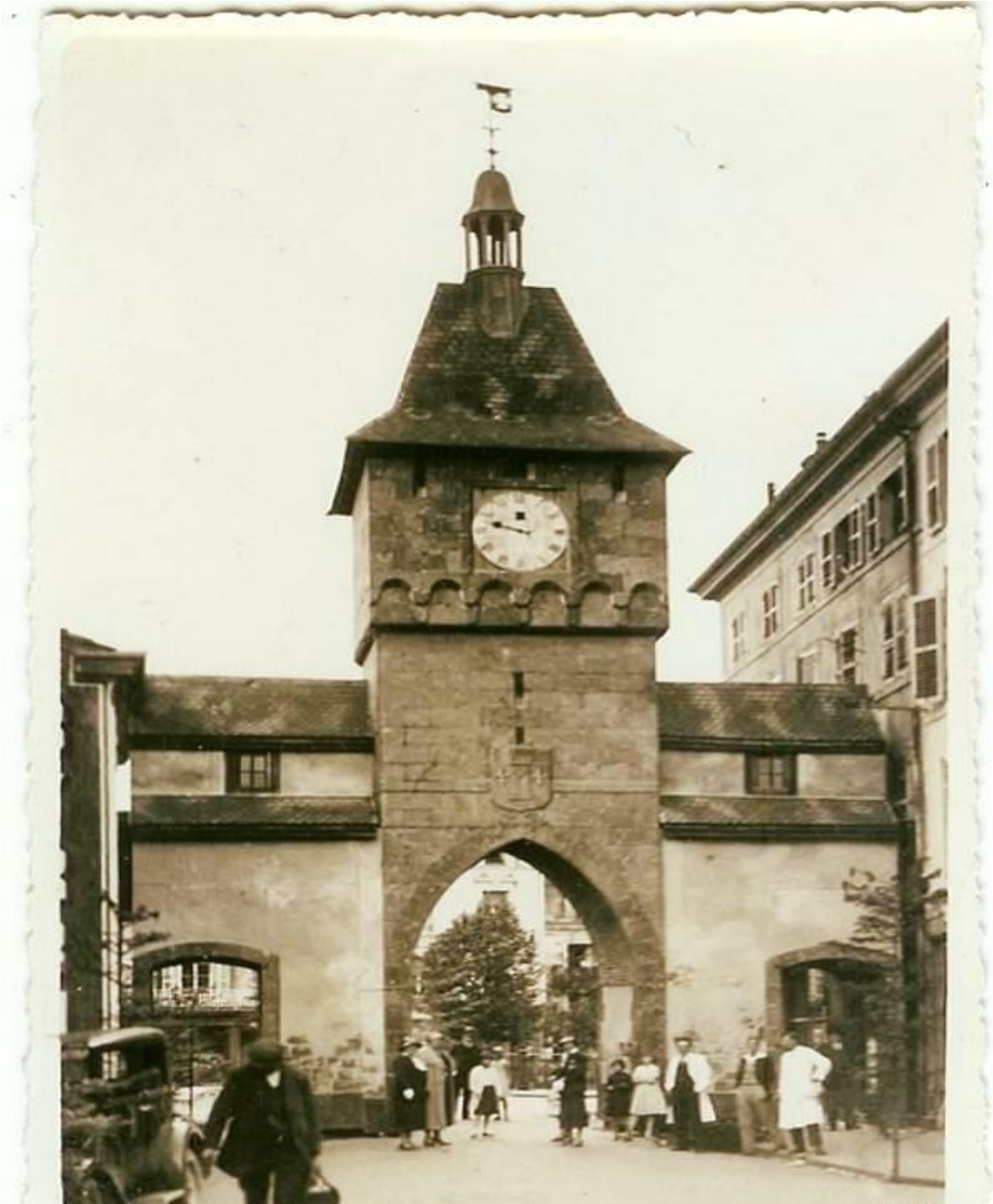
Annexe 5 : Porte de Boudiou. Date inconnue. Collection privée : J. Grasser.
