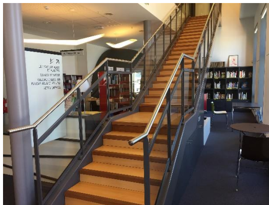
Figure 4 Escalier menant au 2ème étage et signalétique
