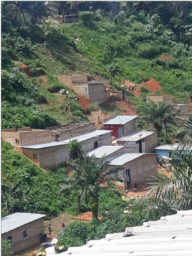
Figure 5 : Maisons situées sur des escarpements propices aux glissements de terrains à Abobo dans le quartier d'Akéikoi Cliché K. Habal TRAORE, 17 juillet 2021
