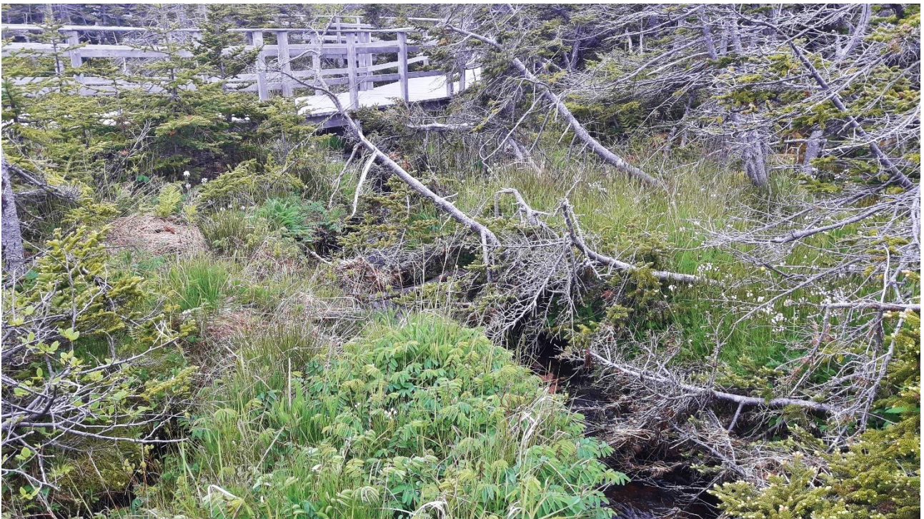
Annexe 45. Photo du tronçon S3 – Ruisseau Savoyard. Une ripisylve non-entretenu se trouve perchée au-dessus du lit mineur, au risque de former des embâcles. Erwan Durand, 15/06/2021.
