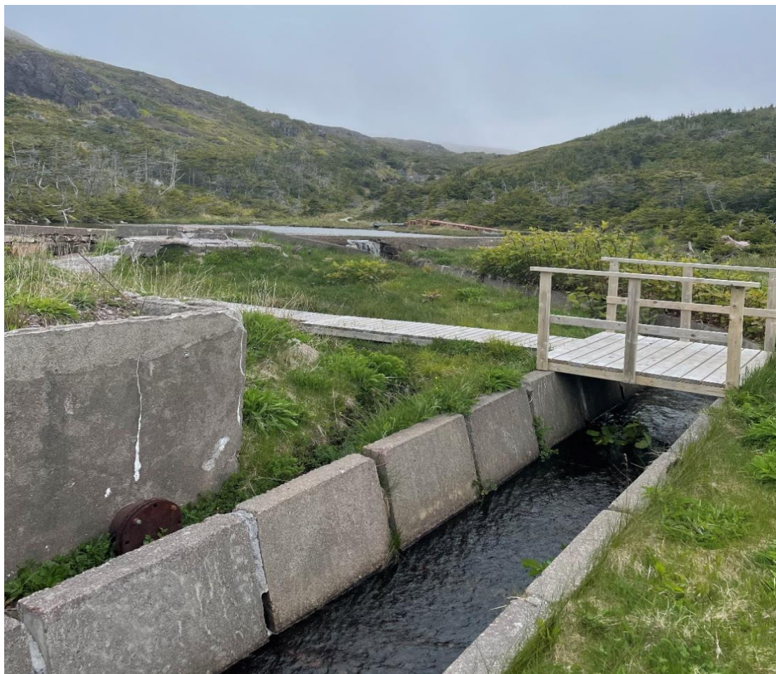
Annexe 43. Photo du tronçon S2 – Ruisseau Savoyard. Un substrat et des berges bétonnées canalisent le cours d'eau recalibré. Edgard Gustave, 15/06/2021.
