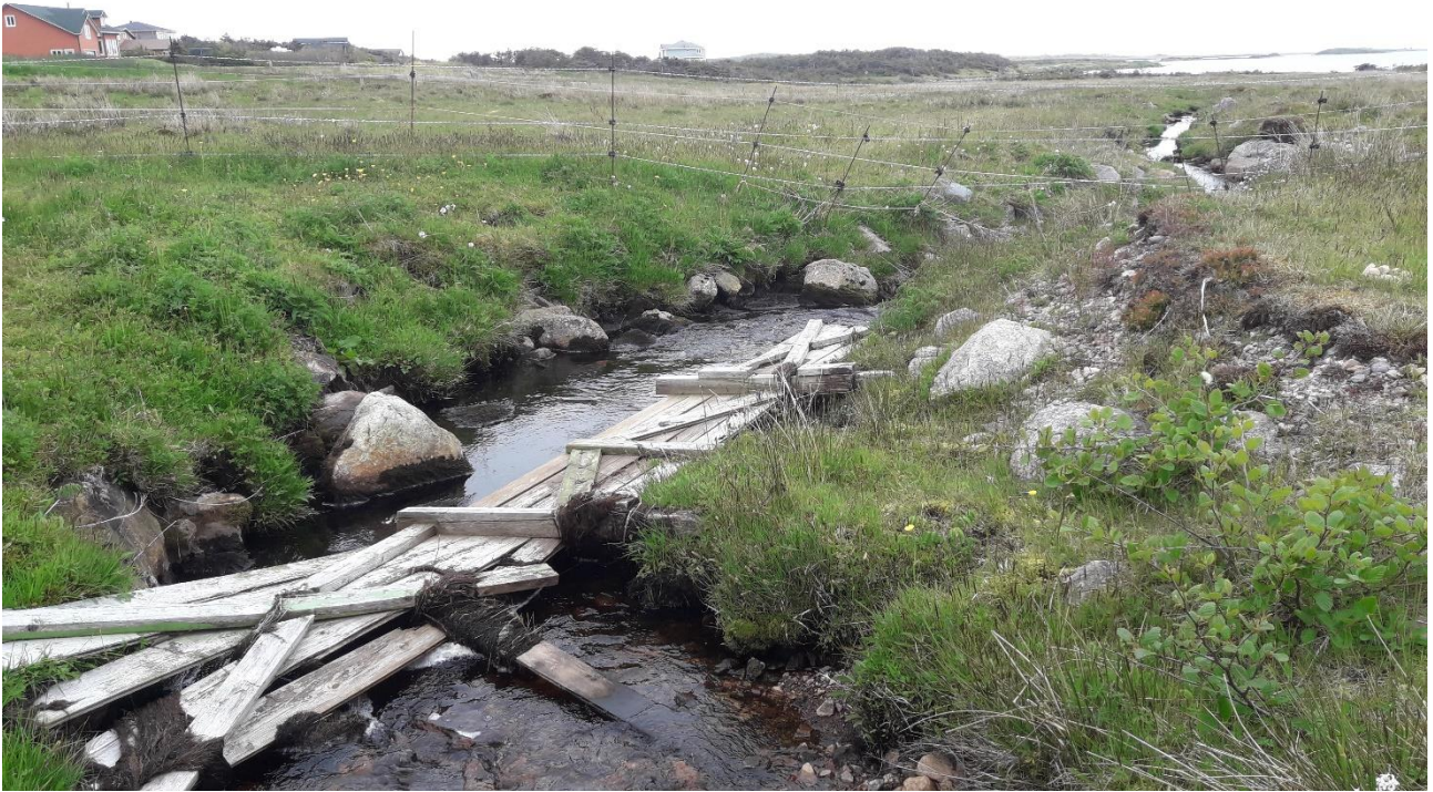
Annexe 46. Photo du tronçon S5 – Ruisseau Savoyard. Le cours d'eau est obstrué par une barrière en bois, censée protéger des berges régulièrement piétinées par les équidés. Erwan Durand, 15/06/2021.
