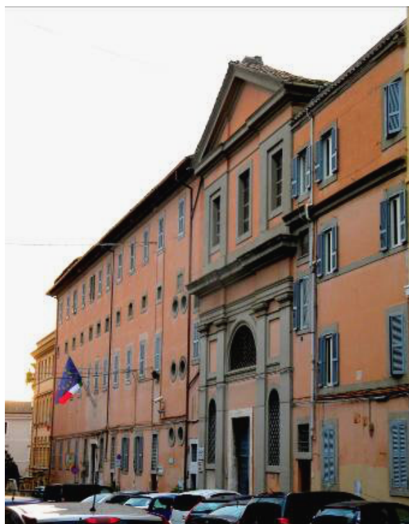
1. Rome, via Sforza, ancien monastère des annonciades célestes, état actuel (cliché de l'autrice).
