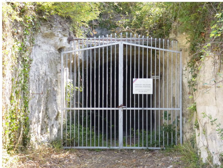
Figure 1 : l'une des entrées de l'ancien entrepôt souterrain américain de Saint-Cyr/Saumoissy. Photographie P. Labrude, juillet 2022.
