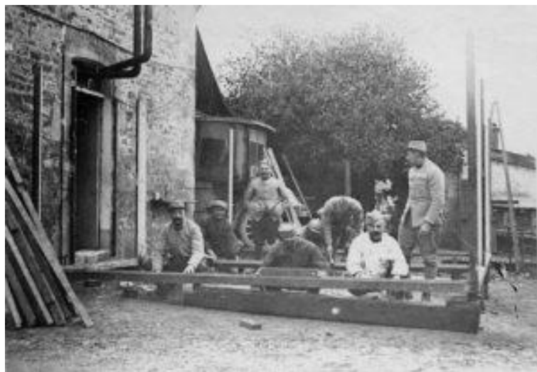
Figure 39 : Montage d'une salle d'opération à Dugny, © Henri Petit
