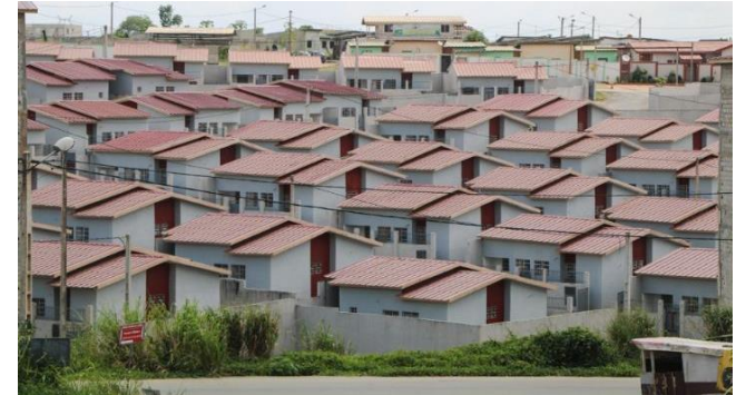
Logements sociaux Bingerville. Crédits photo – Abidjan.net
