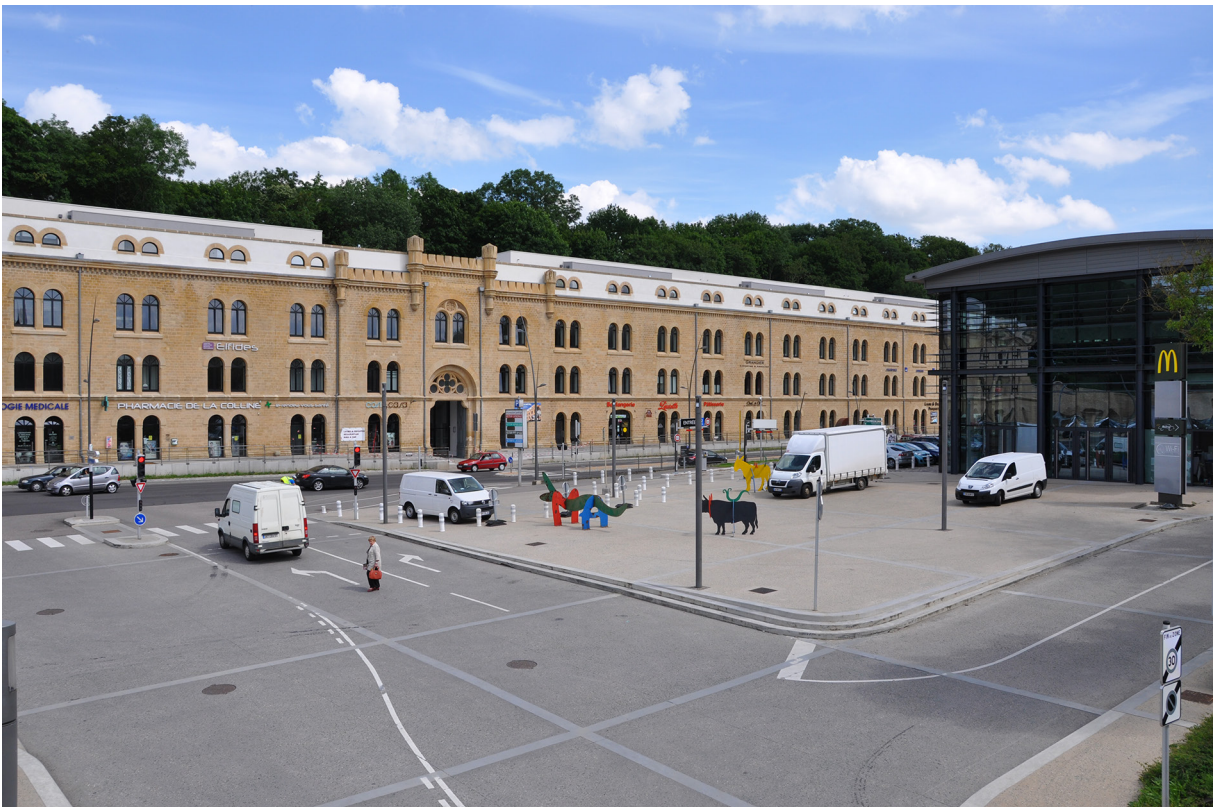
Figures 7 et 8. Le nouveau Boulevard de Trèves après réhabilitation de la première caserne et du magasin à blé : une mise en scène du patrimoine militaire (photographies D. Brion, A. Mathis, 2014).
