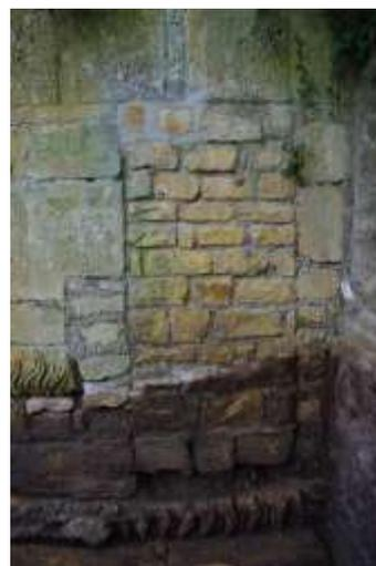
**Figure 55 : Vue générale de la porte obstruée percée dans la canonnière du sondage n° 4 (cliché : J. Trapp)**
