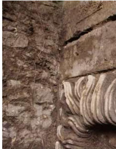
**Figure 37 : La tour ne présente pas de chaînage avec le mur de fausse braie (cliché : J. Trapp)**
