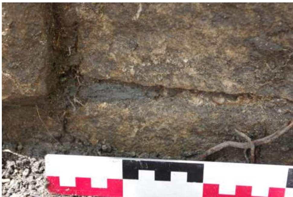
Figure 61: Joints en ardoise observés entre les blocs du sondage n° 5 (cliché : J. Trapp)
