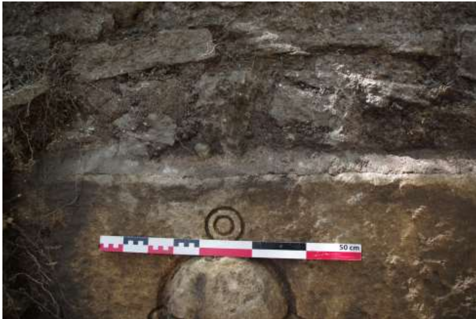
Figure 60 : Couche de mortier recouvrant la partie supérieure des blocs joints au parement du mur de fausse braie (cliché : J. Trapp)
