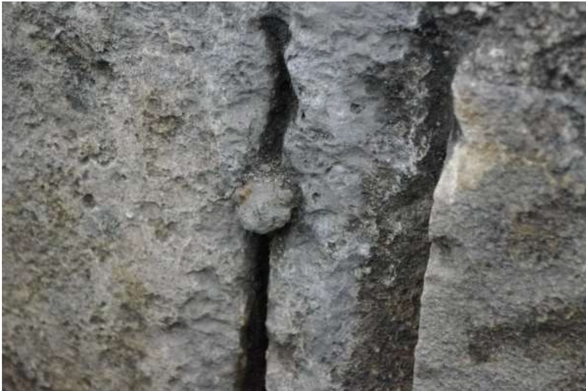
Figure 14 : Clou observé entre les blocs IV et V (cliché : J. Trapp).
