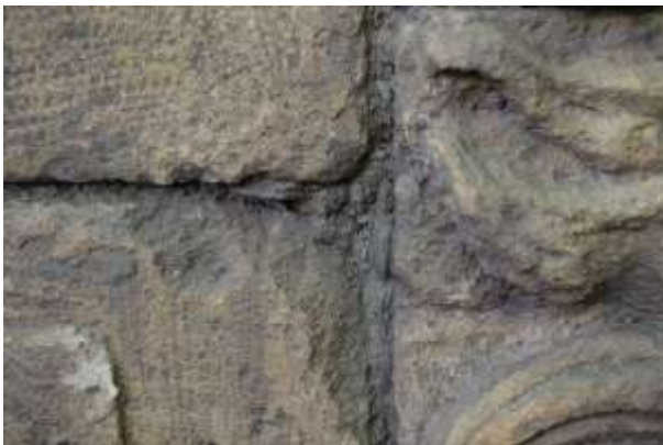
Figure 53 : Vue de détail de joints en ardoise entre les blocs constituant la canonnière du sondage n° 4 (cliché : J. Trapp)
