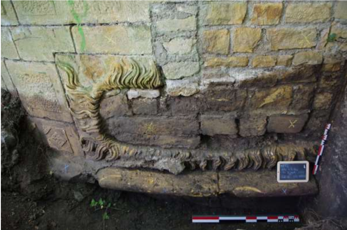
Figure 52 : Vue générale du sondage n° 4 depuis le nord-est (cliché : J. Trapp)
