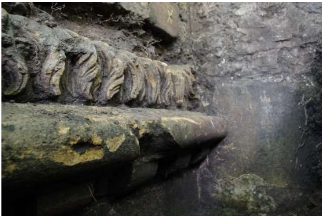
Figure 54 : Vue de détail du boudin et des corbeaux sur lesquels repose la canonnière du sondage n° 4 (cliché : J. Trapp)
