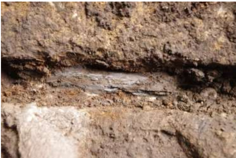
Figure 33 : Vue de détail d'un joint en ardoise (cliché : J. Trapp).
