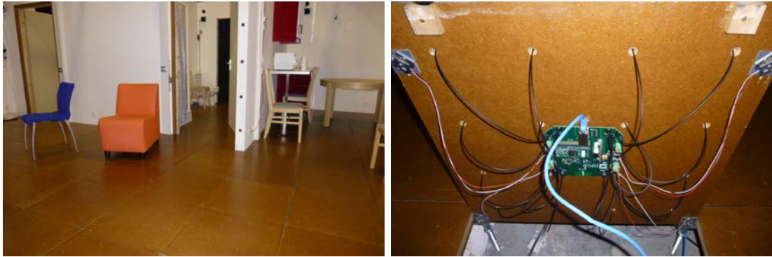
(a) Appartement avec un réseau de dalles au sol.
