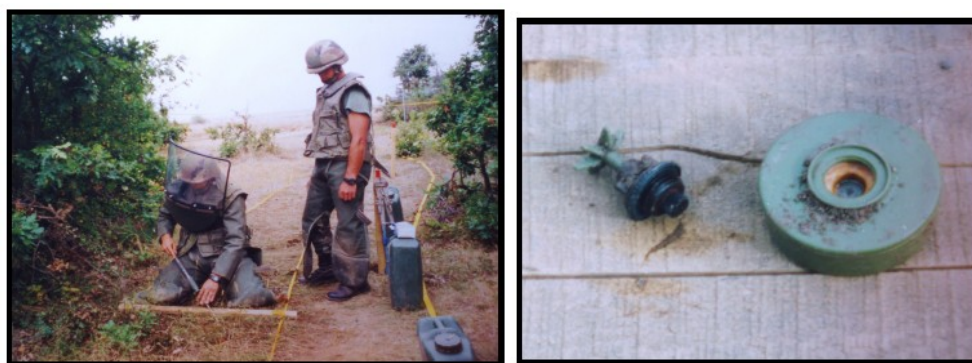
Figure 19 : Chantier de déminage manuel au Kosovo ; Mine antipersonnel de type PMA 2 neutralisée
