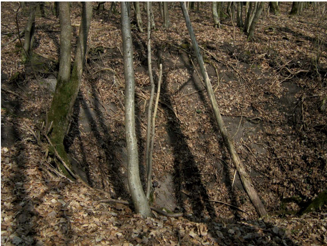
Annexe 13 - Photographie d'une dépression observée lors de prospections de terrains. Cet effondrement est localisé sur les terrains du Keuper supérieur. La structure mesure environ 4 m de diamètre et 3 m de profondeur. Cliché David Etienne.
