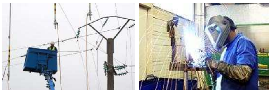
Figure 1.7 : Lignes de distribution électrique et poste de soudure sont des environnements électromagnétiques basses fréquences en milieu professionnel.
