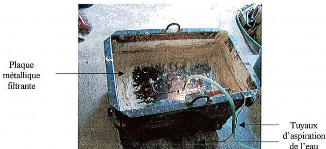
**Figure III.11** : Essorage par le dessus du coffrage
