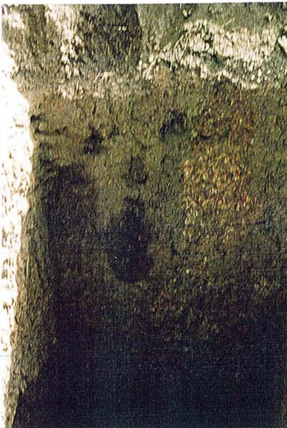
Photo 6. Site B. Infiltration de l'eau des pluies à travers la carapace poreuse en grand contribuant à l'alimentation de la nappe perchée. La carapace sèche apparaît tachetée. Les zones arrondies et de teinte foncée sont humides et indiquent des circulations d'eau dans la porosité tubulaire large de la carapace.
