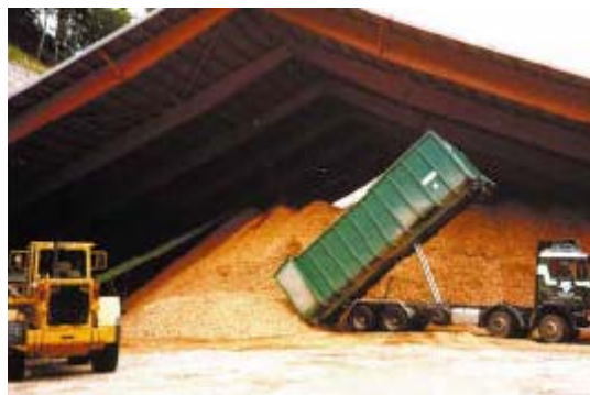
Figure 29 : Stockage et séchage des plaquettes sous abris
