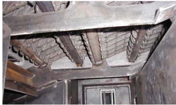
Figure 3-10 : Vue sous le foyer du mode de montage des éléments de grilles (à droite) et du vérin engendrant le déplacement (à gauche).
