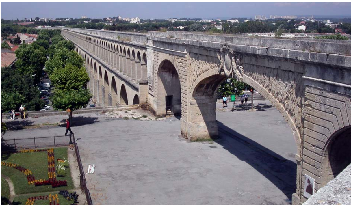
Figure 4-14 : L'aqueduc Saint Clément.
