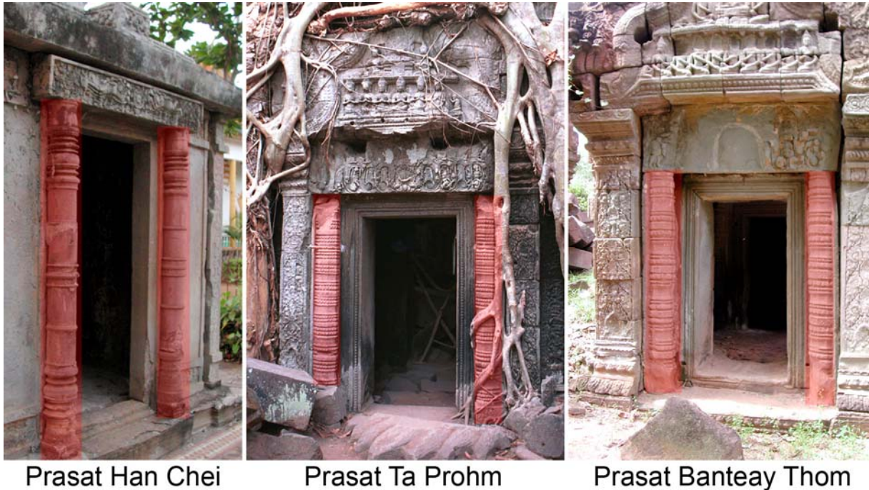
Figure 4-48 : Position de différentes colonnettes au niveau de l'accès des temples khmers (photographies: O. Cunin).
