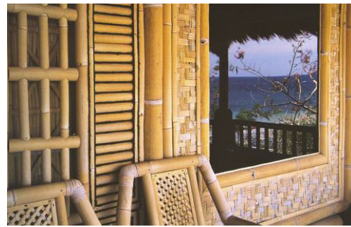
(b) Maison contemporaine à Amed (Bali) qui utilise diverses techniques de construction en bambou
