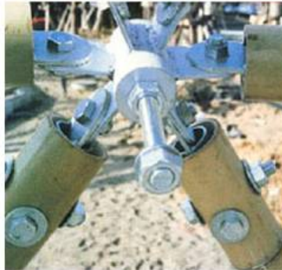
Figure 39: Assemblage imaginé par Yoh [ROT 2009]
