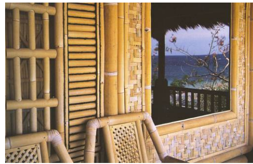
(b) Maison contemporaine à Amed (Bali) qui utilise diverses techniques de construction en bambou
