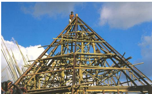
(c) Echafaudage en bambou placé à l'intérieur d'une charpente en construction à Bali
