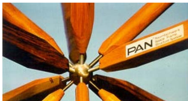
Figure 48: Assemblage utilisant le système Pan® [ROT 2009]
