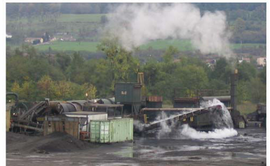
traitement par désorption thermique
