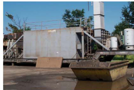
traitement par désorption thermique
