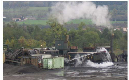
traitement par désorption thermique
