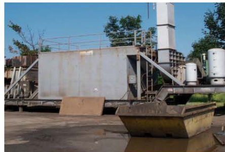
traitement par désorption thermique
