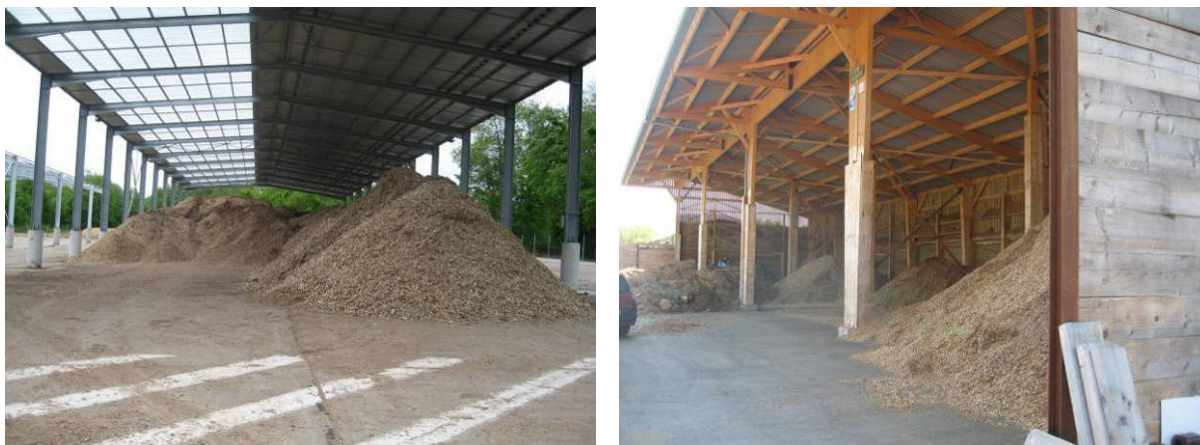
Figure 59 : hangar possédant uniquement un toit (à gauche) Figure 60 : hangar possédant un toit et un côté ouvert (à droite)
