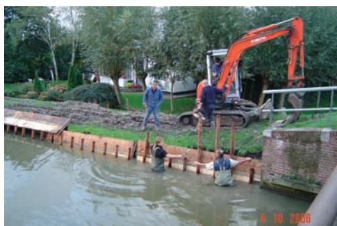
Sheet-piling: Plato®Wood Norway spruce Location: Hoogheemraadschap van Delfland
