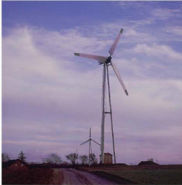
FIG. 1.10 – Éolienne de marque BONUS de 95kW avec tour à trois pieds [2].
