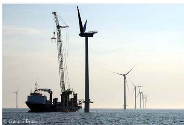
FIG. 1.3 – Installation d'éoliennes offshore en Mer du Nord (Photo Gunnar Britse).
