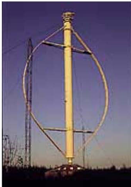
FIG. 1.5 – Eolienne de Darrieus de 4.200 kW et 100 m de diamètre.
