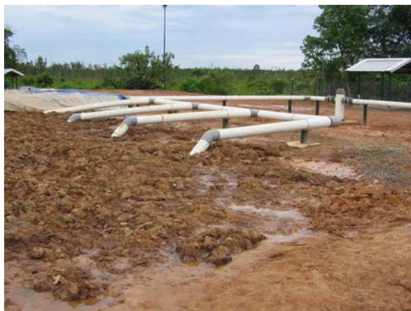
Figure 12: Image de biotertre (ou biopile).
