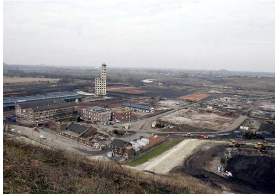
Figure 23: Photographie de Métaeurop Nord en cours de démantèlement.
