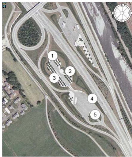
Figure 2.40 : Vue aérienne de l'Aire de Repos de Sainte-Marie-de-Cuines (Point 1 (53 m), 2 (37 m), 3 (93 m), 4 (25 m), 5 (47 m)). D'après document IGN
