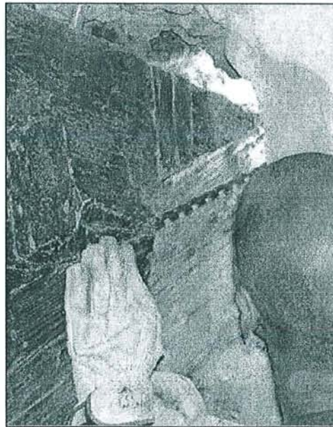
Figure 110 – Réalisation des trous dans l'entrait pour la disposition des tiges en acier.
