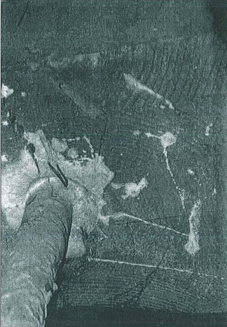
Figure 19 – Bâtiment « B ». Des fentes sont visibles dans la colle autour de la tige et à travers deux lamelles de bois. Même en ce cas, l'effet « coin » de la colle est évident (Figure: Megna).
