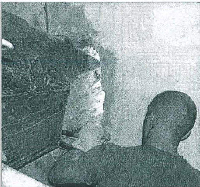
Figure 109 – Elimination des parties de bois dégradées, préparation et nettoyage des surfaces de l'entrait pour accueillir les prothèses à joue.
