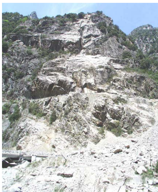
Figure 3 : Résultat de l'éboulement survenu en mai 2000 sur le site des Rochers de Valabres
