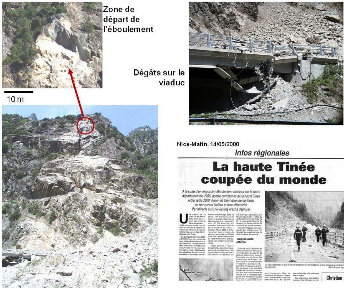
Figure 14 : A gauche : Zone de départ et photographies de l'éboulement survenu en mai 2000. A droite : dégâts occasionnés sur le viaduc et article de la presse régionale. Clichés : CETE Nice.
