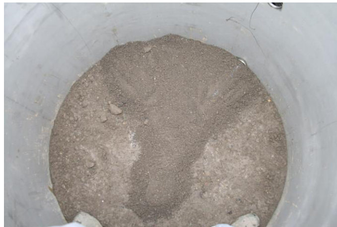
Figure V.4 : Installation des sondes
