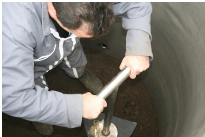
Figure V.3 : Damage d'une couche de terre
